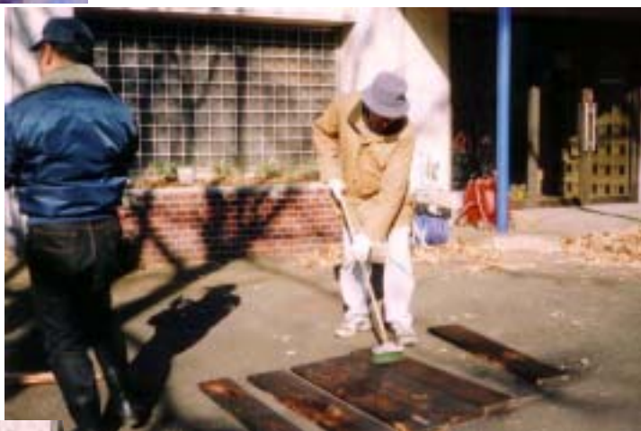
堆肥置き場づくり 焼き板にブラシをかけて表面を磨く。その後、杭打ちをする。
