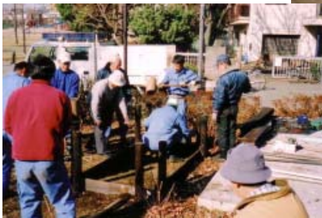
堆肥置き場づくり 焼き板にブラシをかけて表面を磨く。その後、杭打ちをする。
